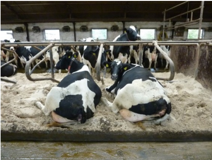
Figur 27. Denne besætning har valgt at banke betonen ud af de oprindelige senge, etablere en ny bagkant og på den måde lave sengene om til sand. Derved undgås en høj bagkant. Som sengene i figur 26 er frontrøret også lavt, og bøjlen god på trods af, at den sidder på frontrør. Det giver nogle ok senge, selvom de er for korte og nakkebommen ikke sidder helt ideelt. Sandet er også en vigtig faktor her, for det hjælper eventuelt halte køer til lettere at komme ned at ligge, i forhold til hvis sengene havde været med madrasser.
