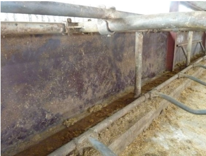
Figur 22. Denne besætning havde en udfordring med at sengene var placeret helt op af staldens ydervæg, som billedet viser her. Det valgte besætningen at gøre noget ved, dog ikke helt med den ønskede effekt. Læg i den forbindelse til mærke til frontrøret og betonhovedpuden her på billedet.
