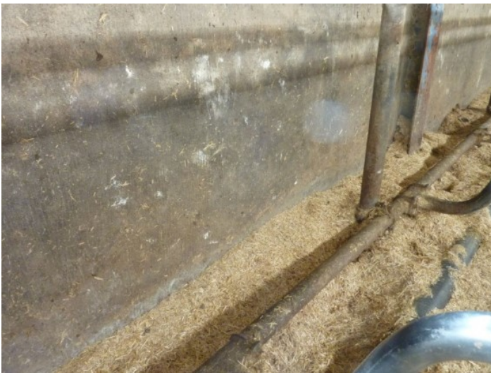
Figur 17. Billedet viser hvor lidt plads der er fra brystbommen og til frontrøret og væggen. Sengene er kun 2,45 m lange. Løsningen vil være at tage ydervæggen ned og flytte gardinet ud, så sengene bliver 3 meter lange. Desuden at skifte sengebøjlerne til en gode sengebøjler på stolper.
