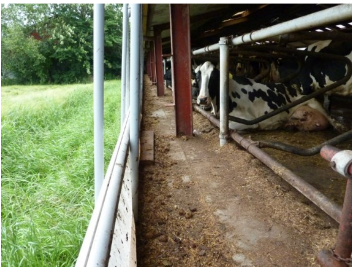
Figur 23. Billedet her viser sengene efter ombygningen. Væggen er væk og gardinet flyttet ud.
