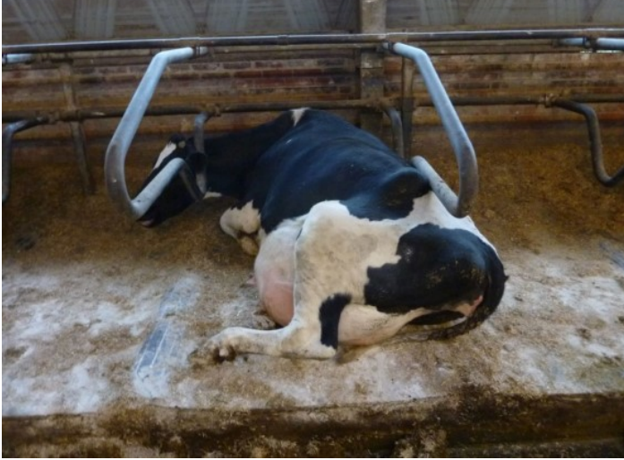
Figur 6. Også sengene i enkeltrækken er for korte (2,52 m; 3,0 m anbefales). For at kunne komme ned og ligge er koen nødt til at stikke hoved under bøjlen og ind i nabosengen. Derved kommer hun til at ligge på skrå og ind under bøjlen.
