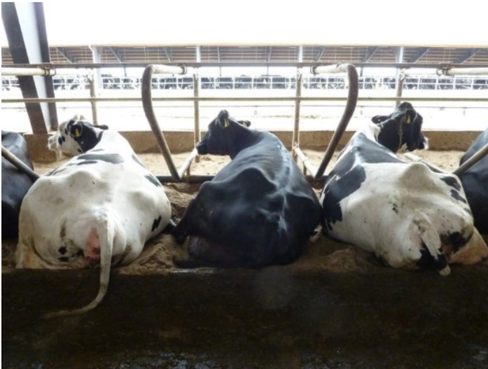
Figur 32. Et af mine favoritsengebåse-billeder. 1,25 m brede og 3 m lange sandsenge, en høj nakkebom (1,3 m) men optimalt placeret i forhold til bagkanten og en korrekt placeret brystbom gør at disse køer ligger helt perfekt. Der er intet foran køerne til at forstyrre og sengebøjletypen er optimal.
